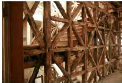
Figura 1: Gaiola Pombalina após remoção da alvenaria
