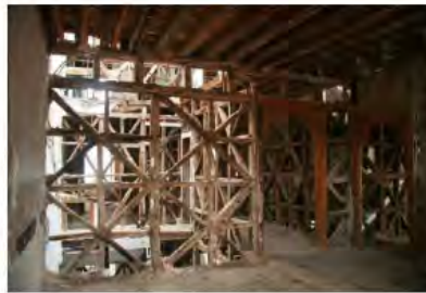
Figura 1: Gaiola Pombalina após remoção da alvenaria
